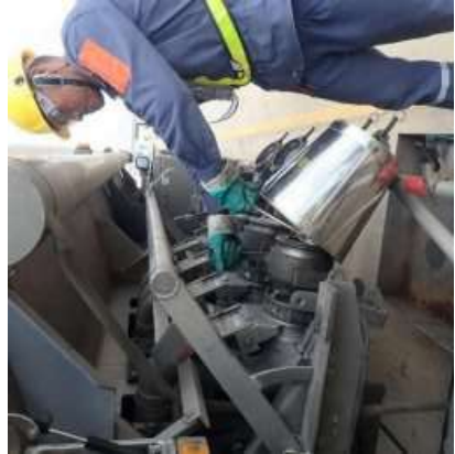
รูปแสดงการ Drain น้ำมันที่ Bottom Drain
