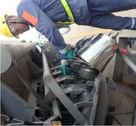
รูปแสดงการ Drain น้ำมันที่ Bottom Drain
