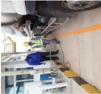
รูปแสดงการต่อสาย กราวด์ ที่ Bottom Drain
